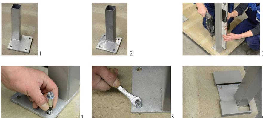
Der Anschluss der Stützen an den Boden ist wichtig für die Stabilität der gesamten Konstruktion. Ein Qualitätsmerkmal sind sogenannte „Stahlfüße“, auf die die Aluminiumprofile „gesteckt“ werden. Es gibt Ausführungen für Eckstützen (1) sowie für Mittelstützen (2). Nach Ausrichtung der Stütze (3) wird diese kraftschlüssig im Boden verankert (4 und 5). Erfolgt die Montage nachträglich auf dem Bodenaufbau, so stehen elegante Verkleidungen in der Farbe des Stützenprofils zur Verfügung (6).
