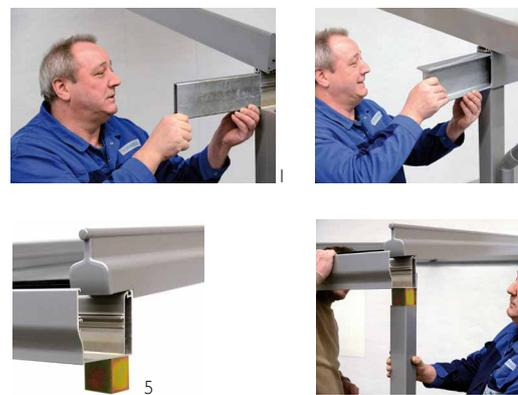
Nach dem gewählten System wird entweder das Fallrohr (1) oder ein Trägerprofil (2) mit verzinktem Stahl verwendet, um die Durchbiegung zu verhindern. Das Fallrohr muss fest am Trägerprofil befestigt sein. Eine Abdeckung mit Moosgummi (4) sorgt für dauerhafte Abdichtung. Besonders stabil ist die Verankerung der Rinne in den Stützen (5). Das Fallrohr kann durch passende Aluminiumblenden (6) verkleidet werden.
